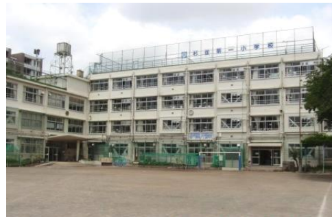
▲杉並第一小学校は今より3.5mも低い河北総合病院の跡地に移転する予定になっている。
